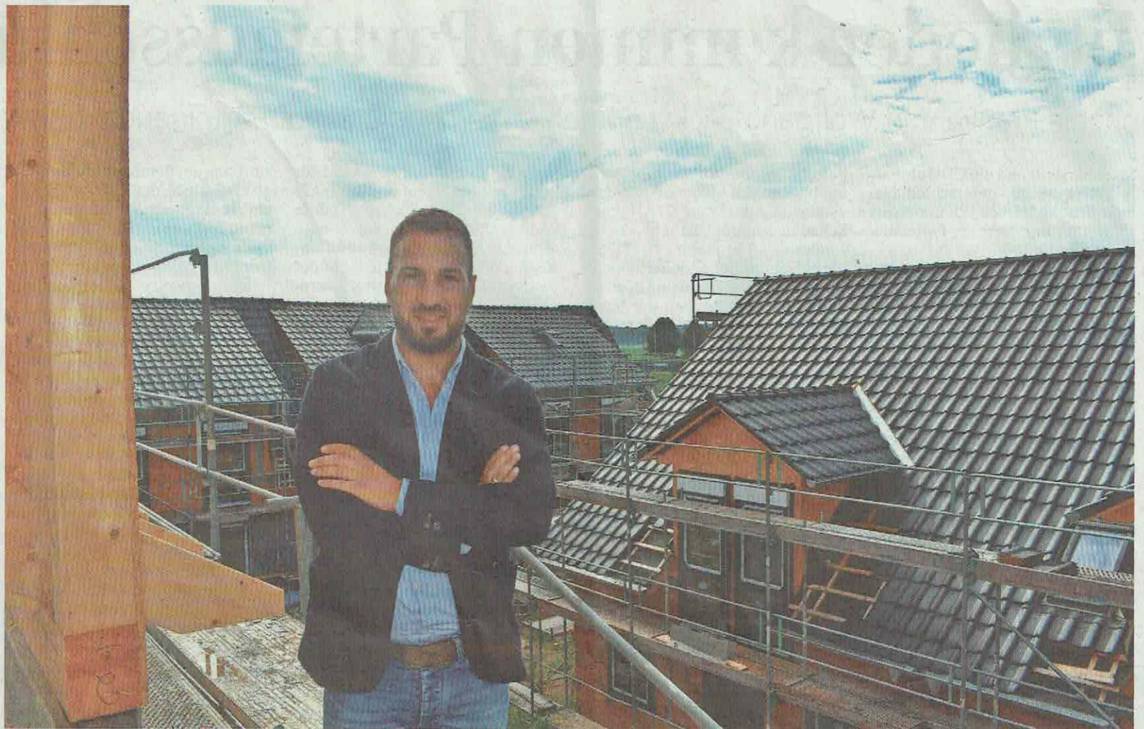
Caner Kaydul steht auf dem Rohbau des Mehrfamilienhauses am Morgenstern, im Hintergrund das Doppelhaus, links die Reihenhäuser. FOTO: SEBASTIAN KNOPPIK
